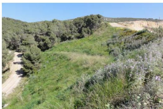
FIGURA 9. Aspecto del talud restaurado con tierras fertilizadas con lodos de depuradora en la actividad extractiva La Falconera. Autor: V. Carabassa.
